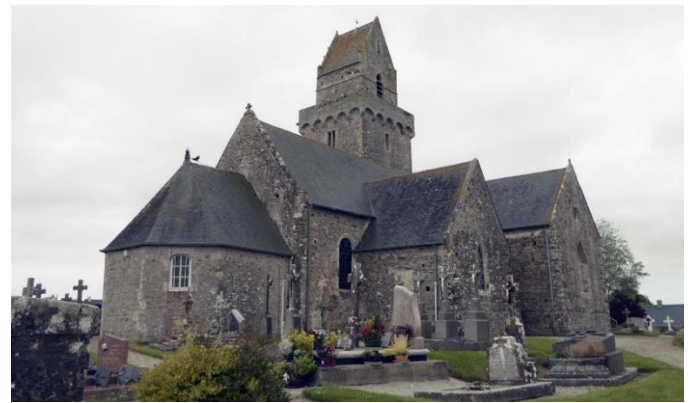
Les deux chapelles latérales (au Nord)
