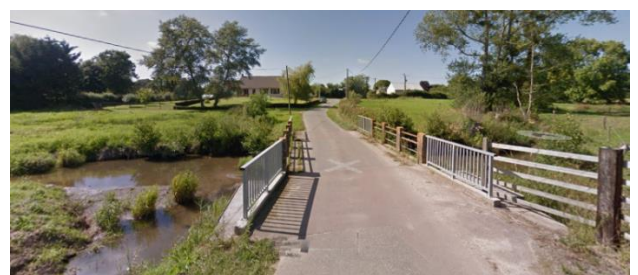
Pont sur le ruisseau le Buisson à proximité du hameau les Mares (Bolleville) à la confluence avec le ruisseau du Moulin
